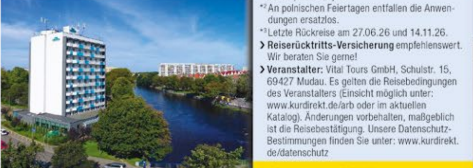
Außenansicht 3+ Aparthotel Nad Parseta
